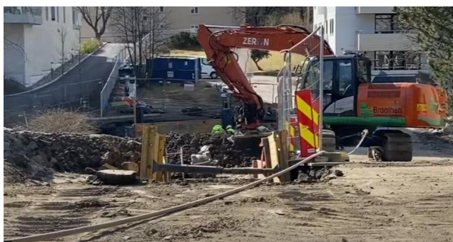
Kabel fra kabelcontainer med trommel tilkoblet gravemaskinen i Lybekkveien. Bilde er skjermdump fra youtubevideo av Nasta.
